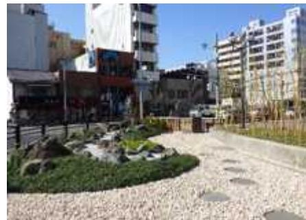
雨水を一時的に貯めてゆっくり地中へ浸透させ、水質浄化や修景機能も併せ持つ「雨庭」
