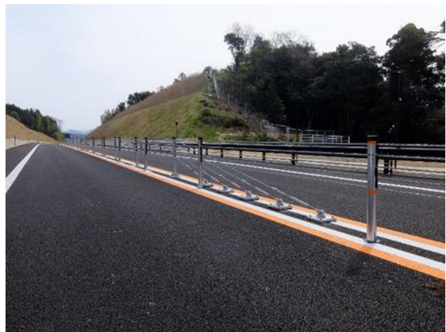
ワイヤーロープ設置イメージ(端部)
