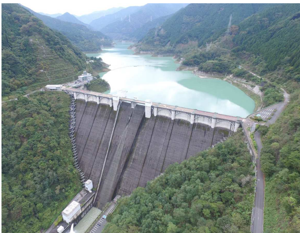
浦山ダム（令和2年10月16日撮影）
