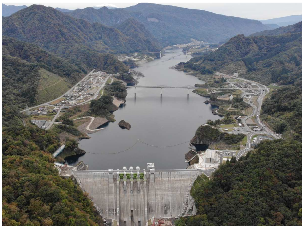
ハッ場ダム（令和2年10月19日撮影）
