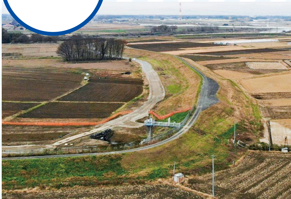
【施工前】2019年12月2日
