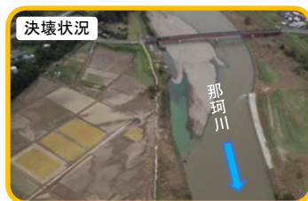
令和元年10月撮影(被災直後)
