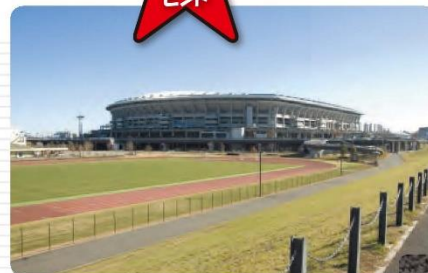
鶴見川多目的遊水地内に建つ日産スタジアム
