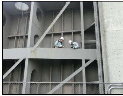
写真-8 板厚測定状況
