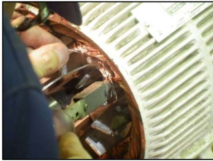
導線を巻き線に固定
