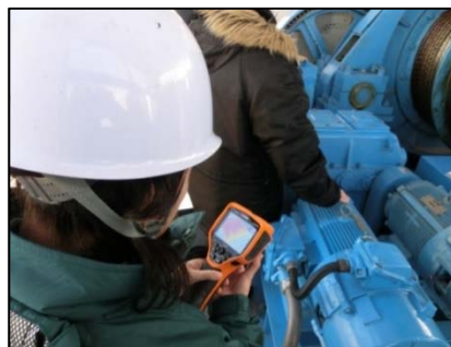
写真-2 赤外線サーモグラフィ
