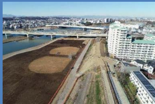
上流部 令和2年12月撮影
