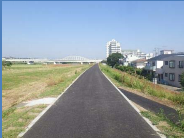
工事着手前(令和3年6月撮影)
