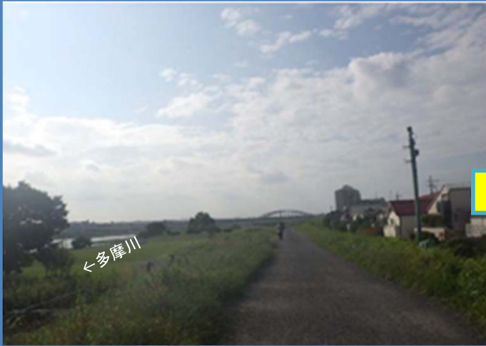
工事着手前(令和2年10月撮影)
