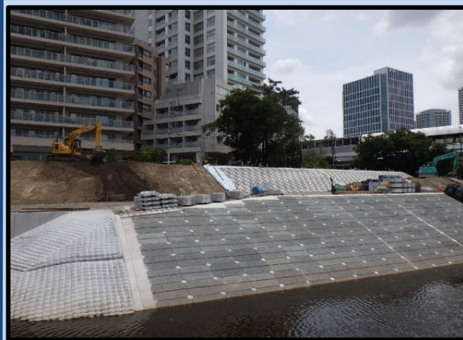
令和3年5月30日、令和元年東日本台風による洪水時の水位まで盛土が完了しました。
