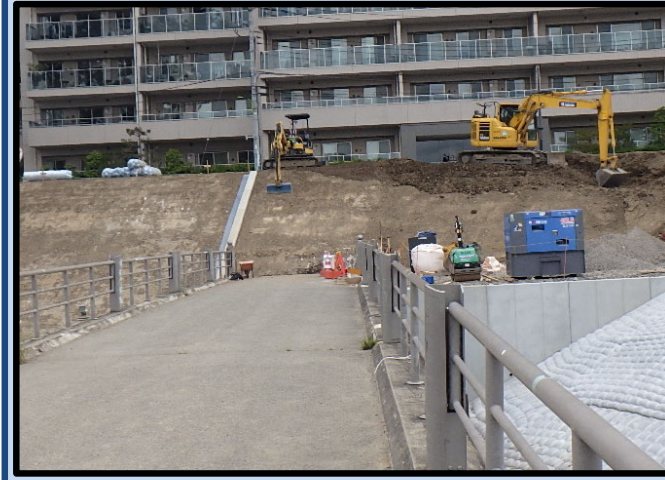
令和3年5月撮影 昨年設置した大型土のうを撤去し、堤防部分の盛土を進めています。
