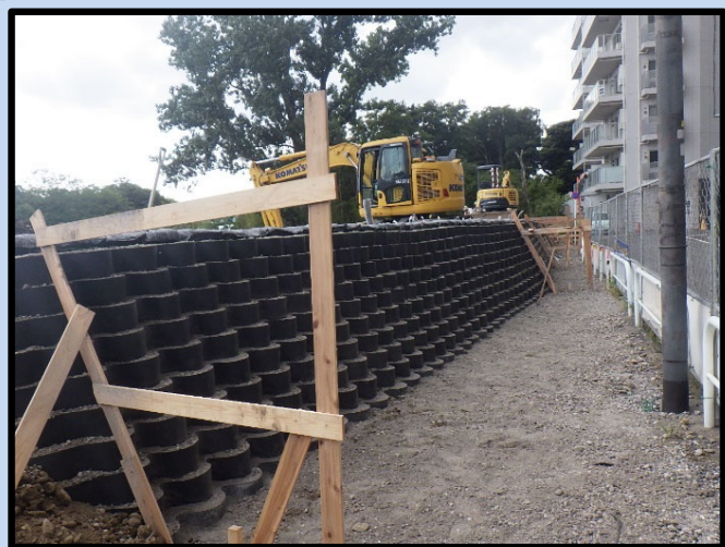
令和3年5月30日、令和元年東日本台風による洪水時の水位まで盛土が完了しました。
