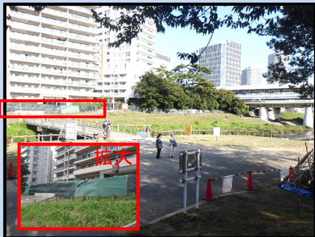
工事着手前 令和2年9月撮影 令和2年6月に大型土のうを設置しました。
