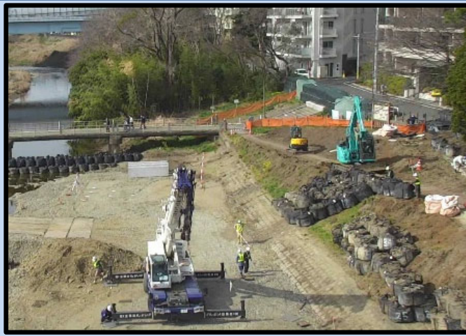
令和3年3月撮影 盛土を進めています。
