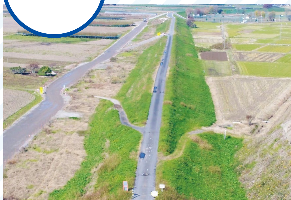
【施工前】2019年10月30日
