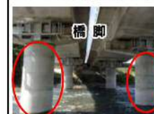
＜橋梁の耐震対策＞
