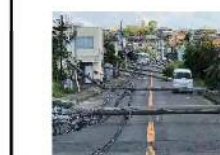
＜電柱倒壊による道路閉塞＞
