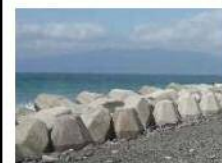
＜消波・根固ブロック＞
