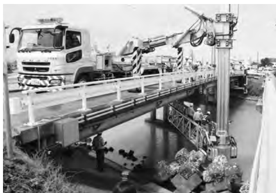
写真－9 古川橋（静岡県榛原郡吉田町）(中部 MC)
