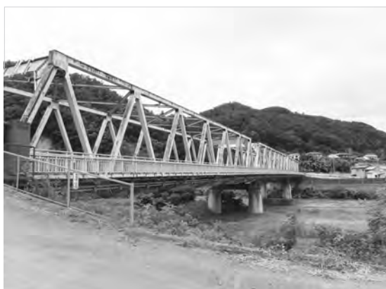
写真－3 国道 19 号 穂刈橋（関東 MC）
