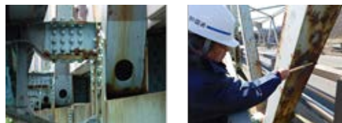
写真1 特殊橋梁の補修設計を代行 (トラス橋の格点部の補修に係わる技術支援)
