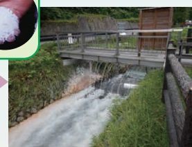
石灰石粉を混ぜた水を川に戻して中和させる
