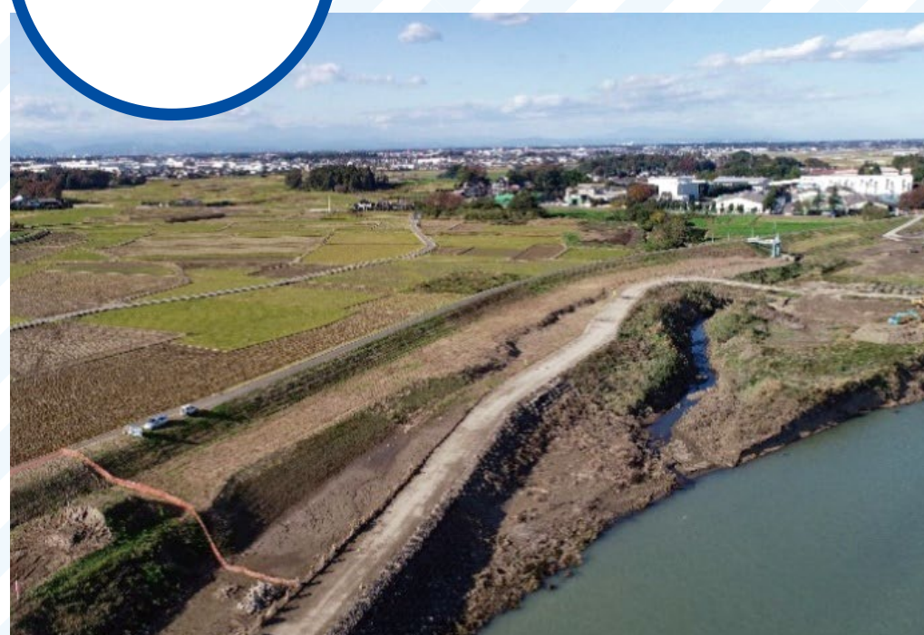
【施工前】2019年11月12日
