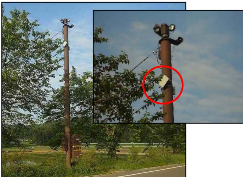
アンテナ高さを確保するためCCTV支柱へ設置
