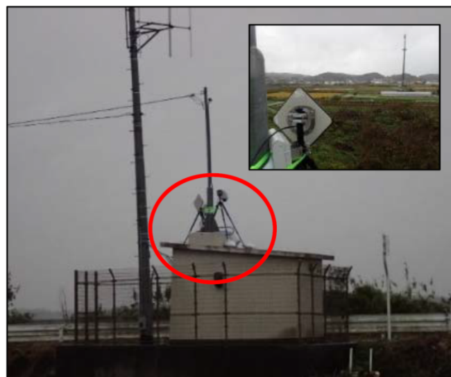
テレメータ局舎上部へ設置
