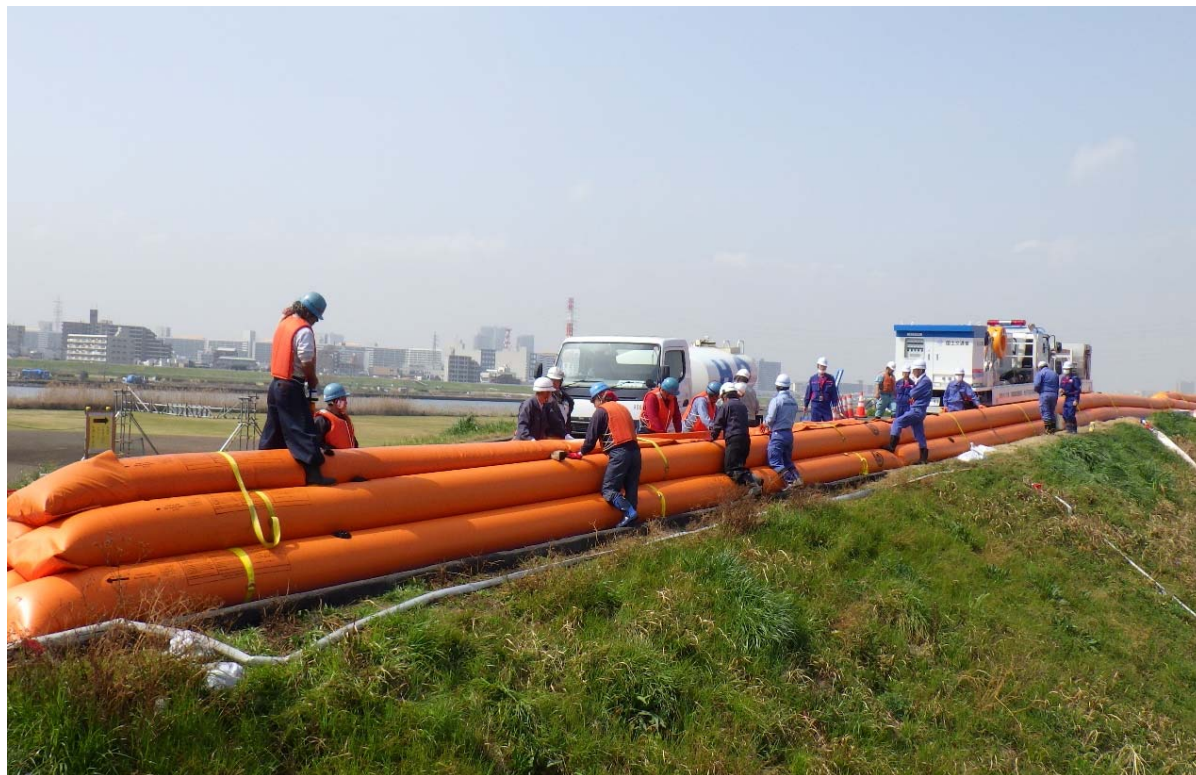
水のう設置訓練の実施(荒川下流河川事務所)
