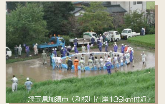
▲平成13年9月 台風15号出水に伴う漏水状況
