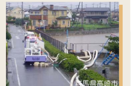
▲平成19年台風9号出水時の排水ポンプ車の派遣状況
