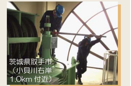
▲河川管理施設の点検状況 (北浦川水門)
