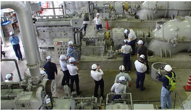
図-2 現場試行の視察状況（点検員が試行する周囲で視察者は状況を記録している）
