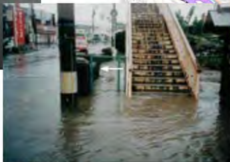
平成10年8月 休泊川(大泉町中央付近)
