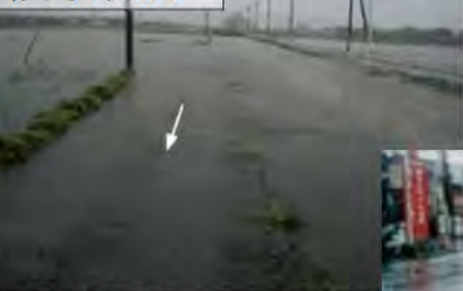
平成23年7月 新堀川(邑楽町大字狸塚付近)
