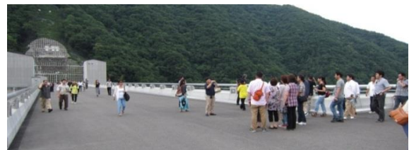
湯西川ダム本体見学状況
