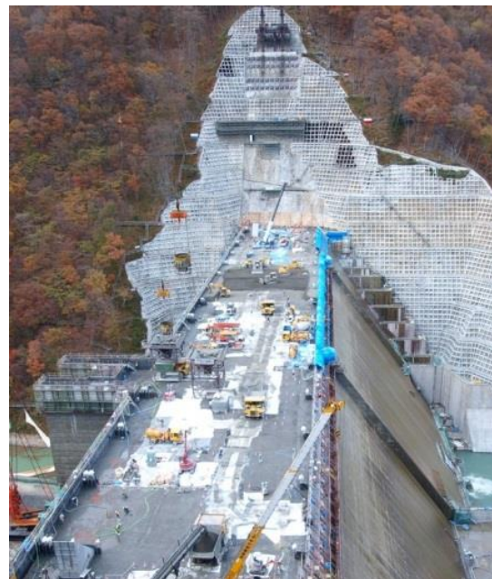
本体コンクリート打設状況
