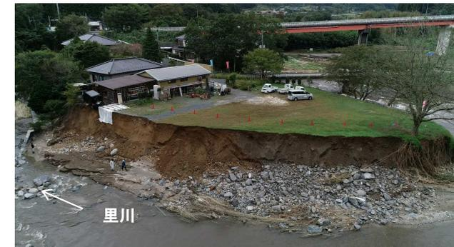
写真② 河岸洗掘箇所 (常陸太田市, R1.10 東日本台風)
