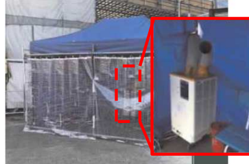
テントと併せて送風機やスポットクーラー、ドライミスト発生装置等を追加設置
