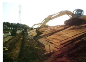
築堤工事の状況
