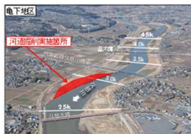
河道掘削(亀下地区)
