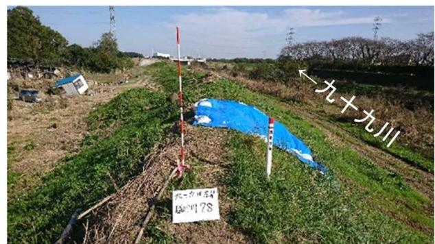
図 3.2.9 越辺川 (九十九川) 左岸 7.6k と 7.8k の洪水痕跡
