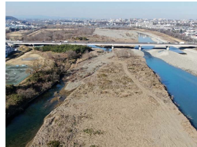
完了(令和2年3月撮影)
