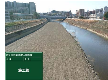
完了(令和2年3月撮影)
