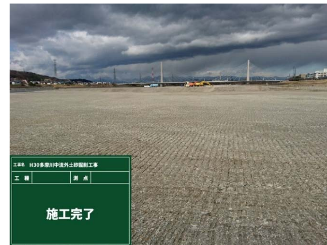
完了(令和2年2月撮影)
