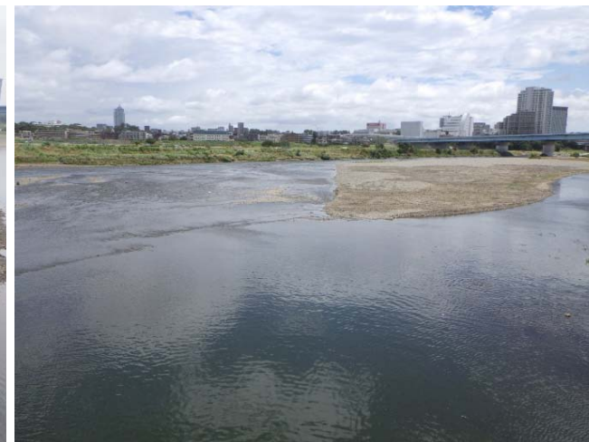
完了(令和2年6月撮影)
