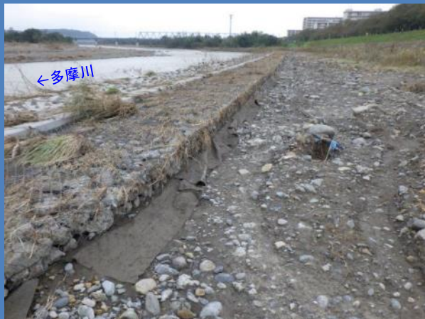
工事着手前（令和元年12月撮影）
