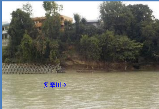
工事着手前（令和元年10月撮影）
