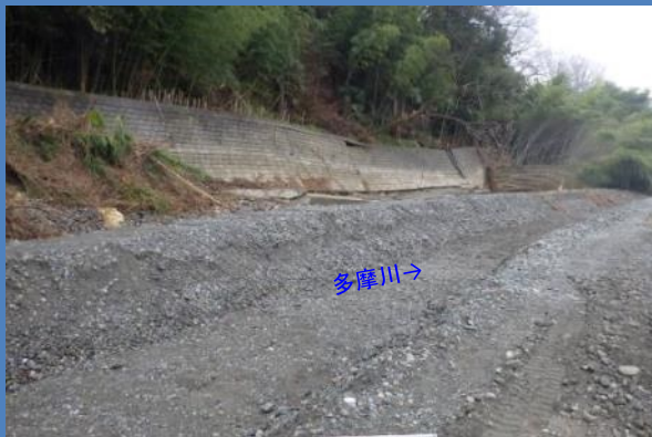
工事着手前（令和2年2月撮影）
