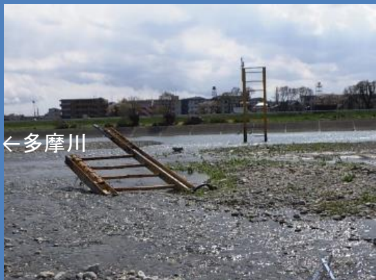
多摩川三丁目地先 工事着手前(令和元年10月撮影)
