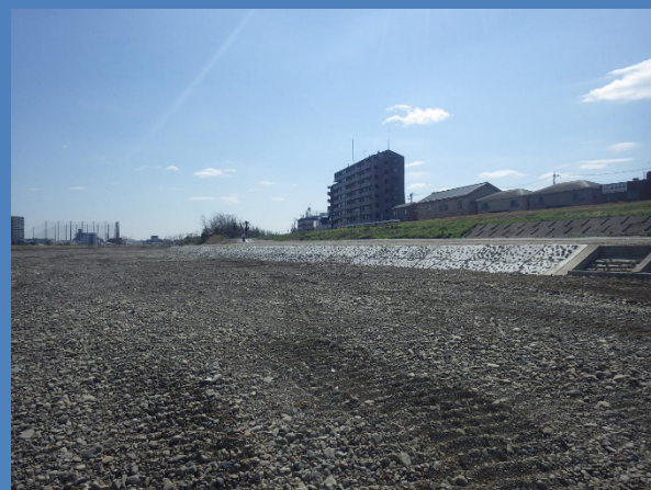
押立地先(令和3年3月撮影)
