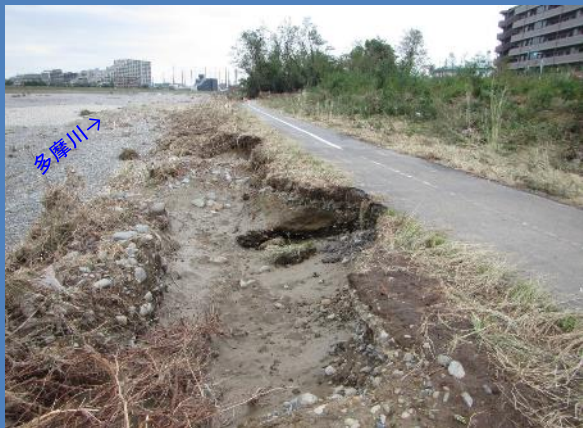
工事着手前（令和元年10月撮影）
