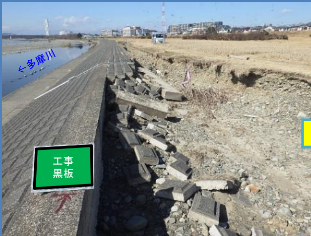
工事着手前（令和元年10月撮影）
