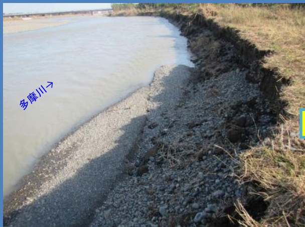
工事着手前(令和元年10月撮影)
