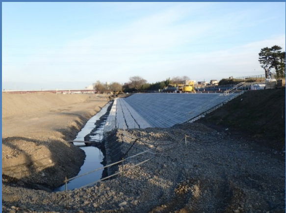
護岸ブロックを設置しました。
