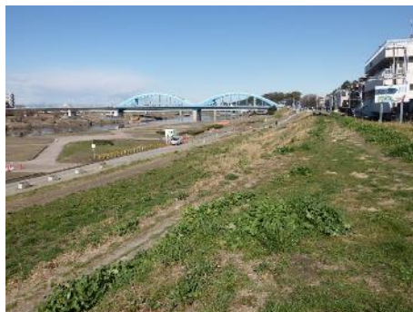
工事着手前(令和元年10月撮影)
