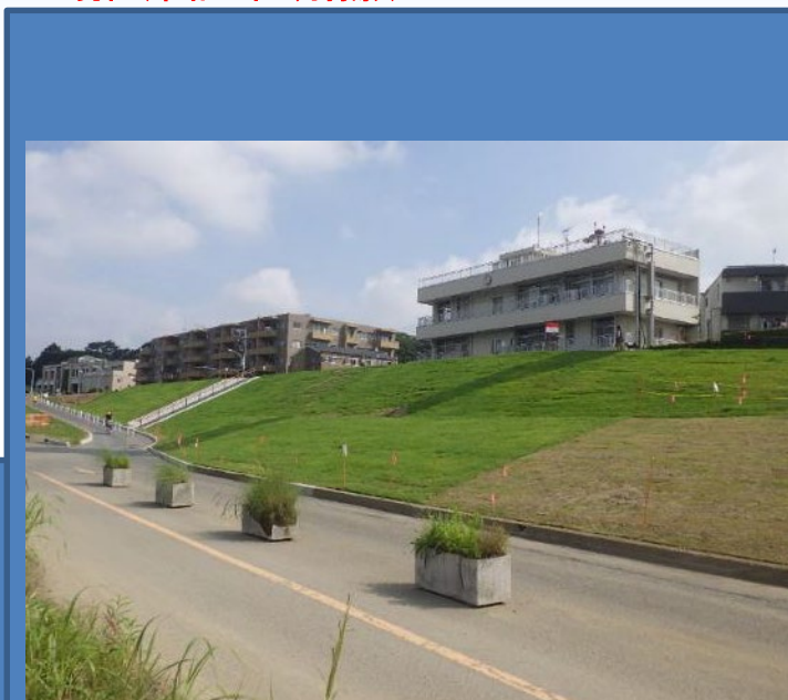
堤防の復旧が完了しました
