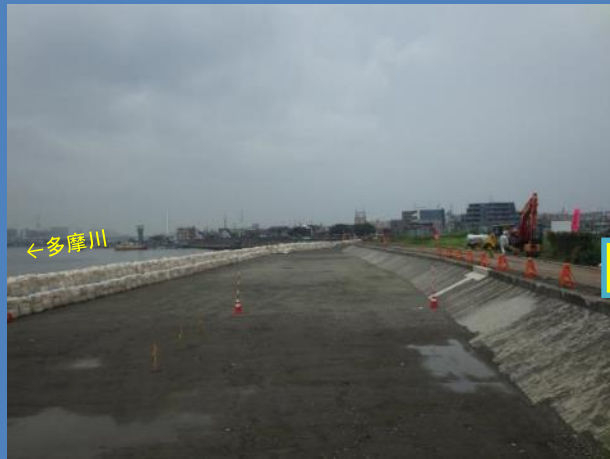
工事着手前(令和2年6月撮影)
