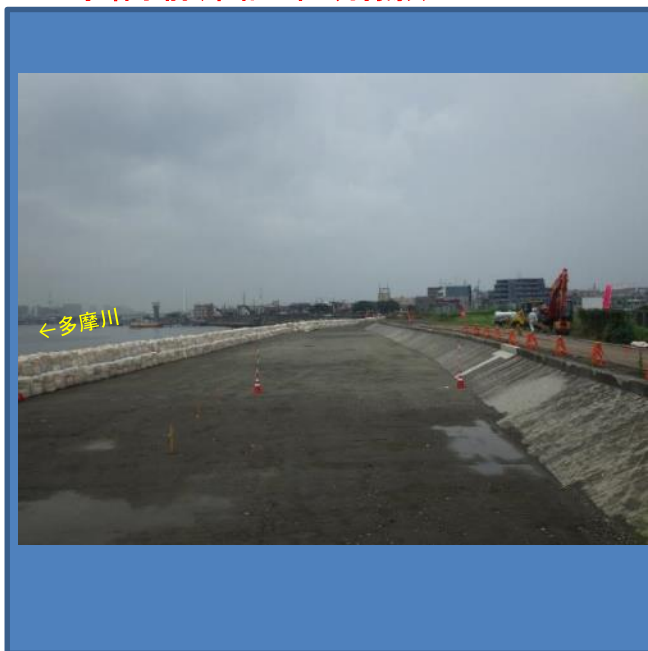
工事着手前(令和2年6月撮影)
