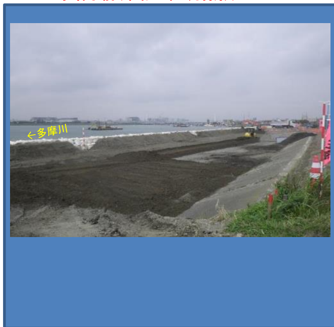
工事着手前(令和2年6月撮影)
