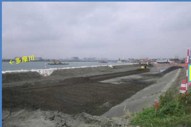
工事着手前(令和2年6月撮影)
