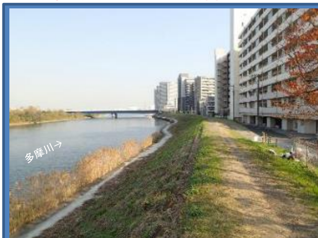
工事着手前(平成30年11月撮影)
