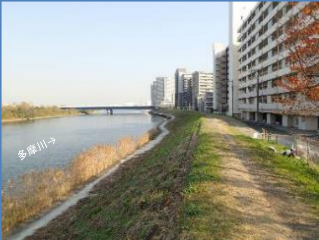
工事着手前(平成30年11月撮影)
