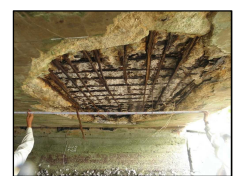
内部の鉄筋が露出した橋梁
