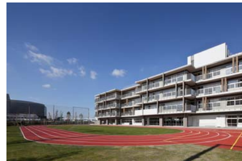
校庭貯留 (江東区 豊洲西小学校)
