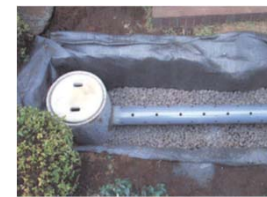
浸透トレンチ
