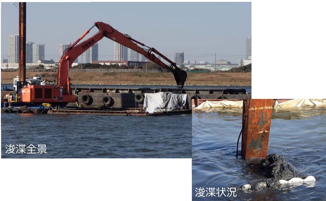
浚渫の実施状況
