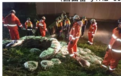
土のうの設置
