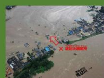
鬼怒川の堤防決壊箇所
