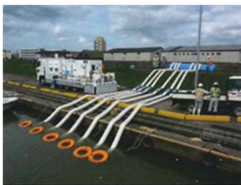
排水ポンプ車による排水状況
