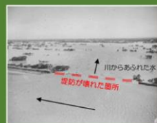
利根川の堤防決壊箇所
