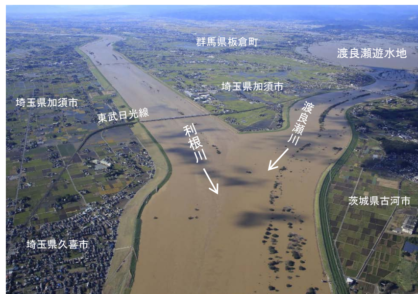
令和元年10月台風第19号による出水時の利根川と渡良瀬川合流点付近の状況
