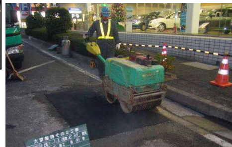
〈路面補修状況（パッチング）〉
