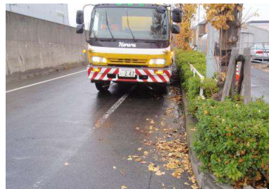
〈路面清掃状況（機械）〉
