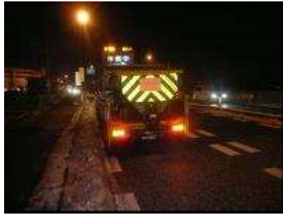
〈凍結防止剤散布状況〉
