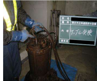
〈排水設備 定期点検状況〉
