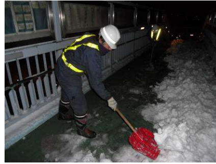
〈歩道橋除雪作業状況〉
