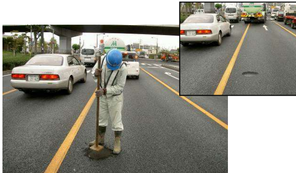
〈路面補修状況（ポットホール補修）〉
