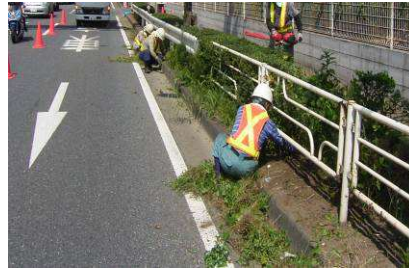
〈抜根除草状況（植樹帯）〉
