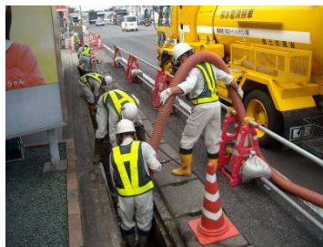
〈側溝清掃状況（機械）〉
