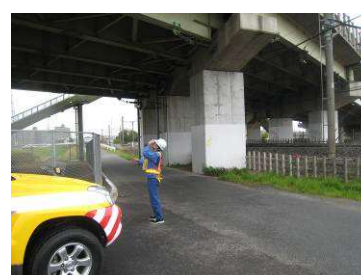
〈橋梁の確認状況〉
