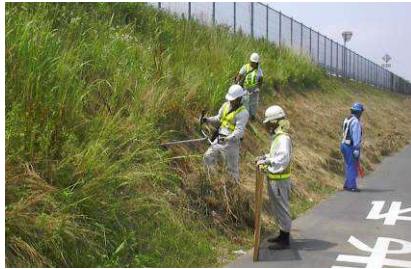
〈機械除草状況（法面）〉
