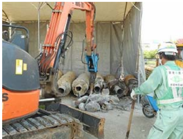
写真－６ 照明柱基礎撤去状況
