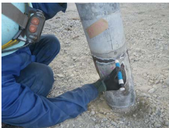
写真－７ 変状箇所確認調査状況
