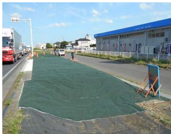
写真-3 施工例（シート系）
