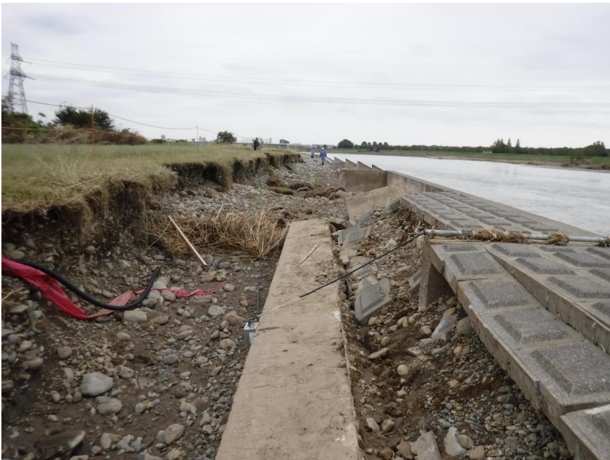
⑭多摩川 30. 6k 左岸（東京都府中市） 低水護岸崩壊 L=120m
