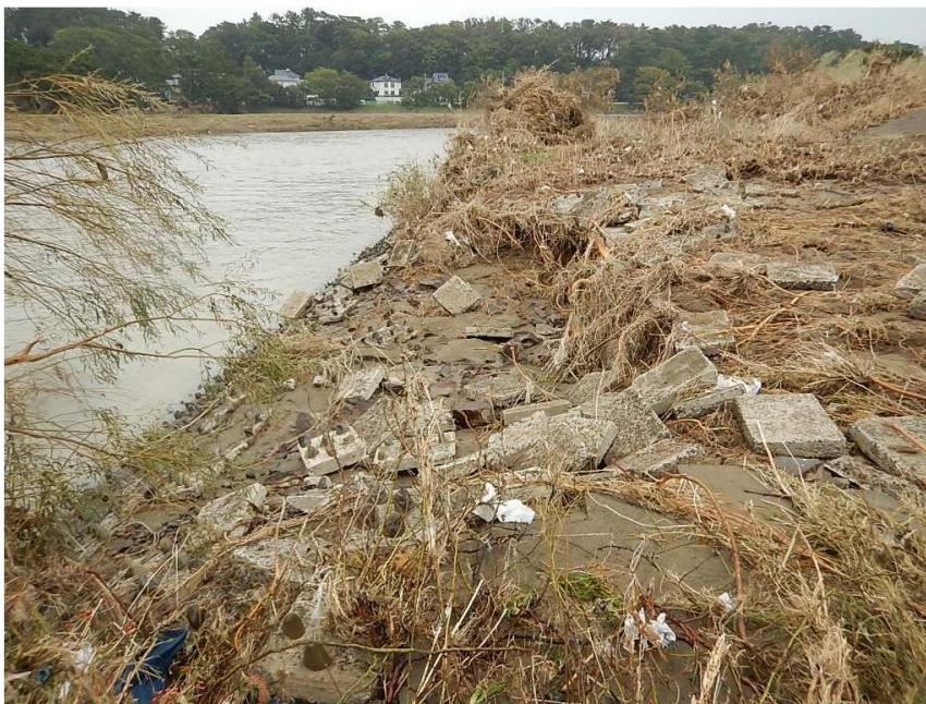
⑥多摩川 19. 4k 左岸（東京都世田谷区） 低水護岸崩壊 L=91m
