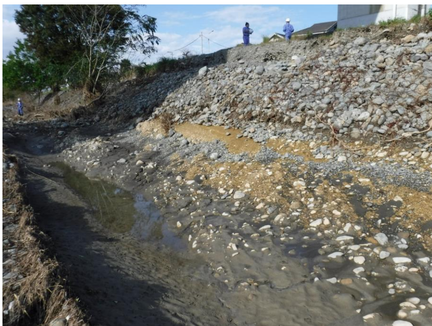
②0多摩川 53. 2k 左岸（東京都羽村市） 低水護岸崩壊 L=76m
