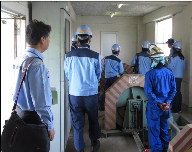
樋管の動作確認
