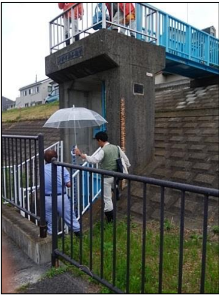
樋管の開閉状況の確認
