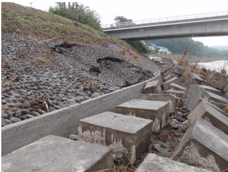
②0多摩川 53. 2k 左岸（東京都羽村市） 低水護岸崩壊 L=76m
