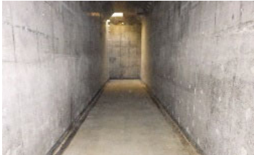
雨水貯留浸透施設のイメージ
