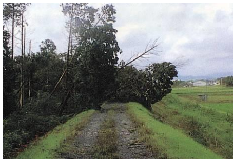
倒木により堤防へ影響
