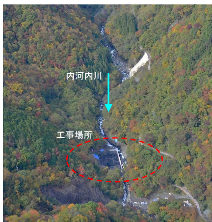
工事場所 の状況
