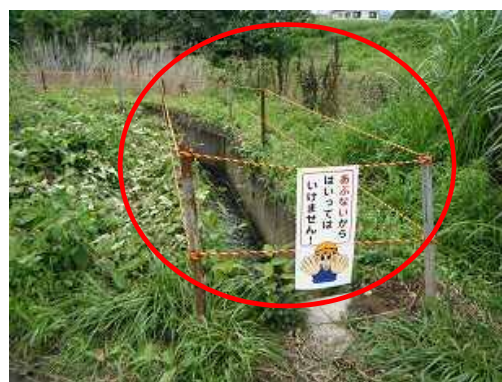
ロープ補修及び看板設置
