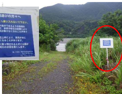
注意看板を復旧
