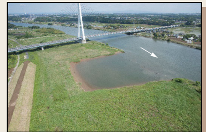
▲河道掘削試験施工地(那珂川下流部)
