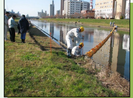
▲水質事故時における対策状況
