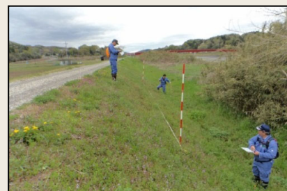
▲堤防点検状況
