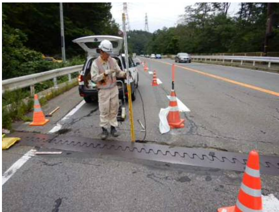
東山橋応急規制状況
