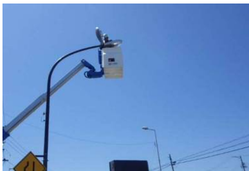
照明灯電球交換作業
