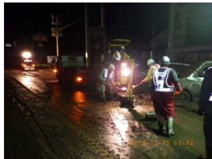
土砂撤去作業
