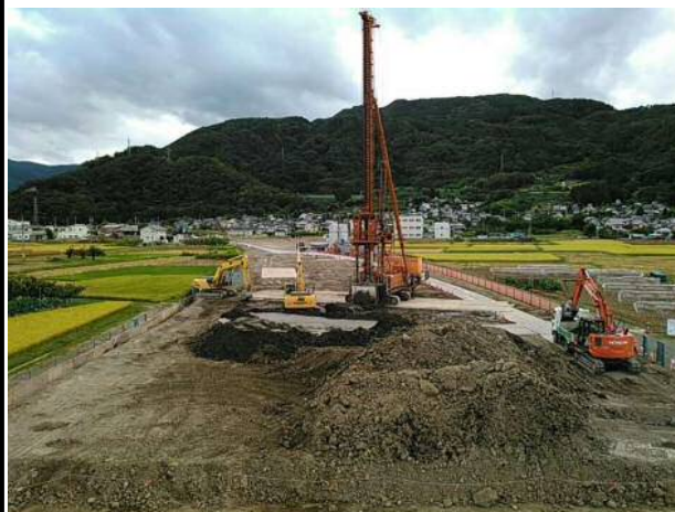
地盤改良工施工状況
