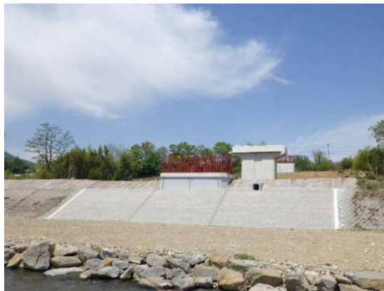
P8橋脚 完成
