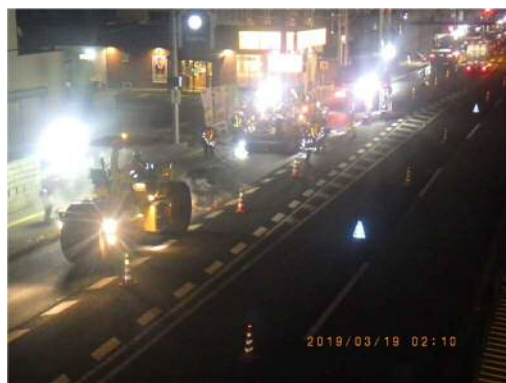
舗装夜間作業
