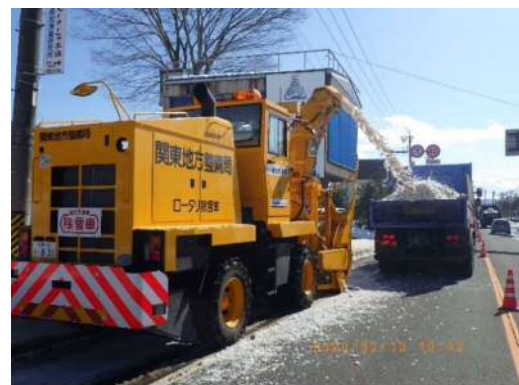
拡幅除雪作業
