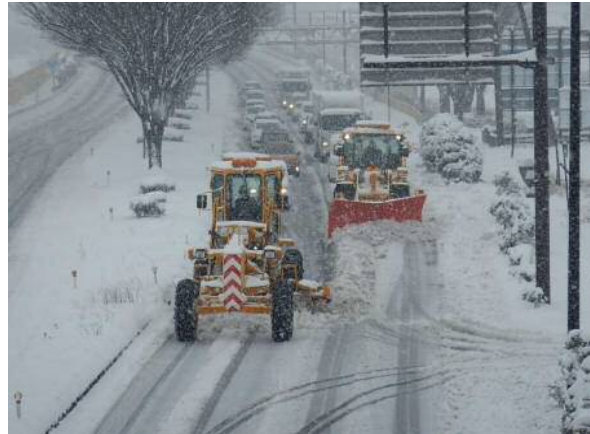
除雪作業状況
