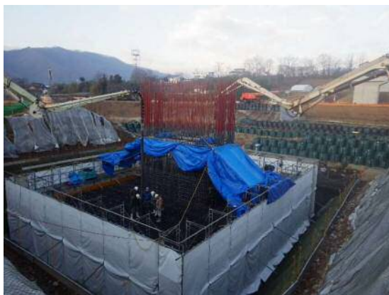
P8橋脚施工状況
