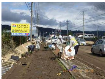
土砂撤去作業
