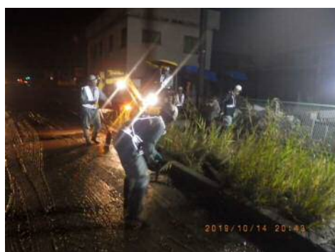
土砂撤去作業
