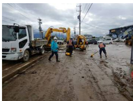
土砂撤去作業
