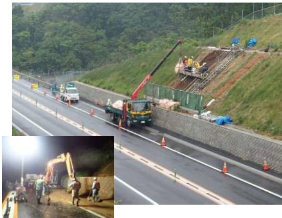
法面崩落復旧作業施工状況
