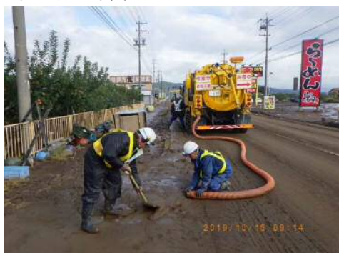
土砂撤去作業
