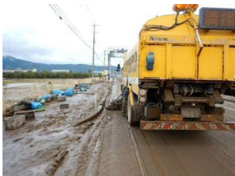
土砂撤去作業
